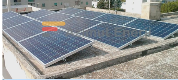
Solar Güneş Enerji Ev Sistemleri Düz Çatı Solar Panel Uygulama.
