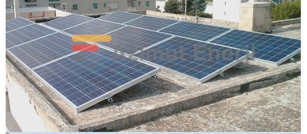
Solar Güneş Enerji Ev Sistemleri Düz Çatı Solar Panel Uygulama.
