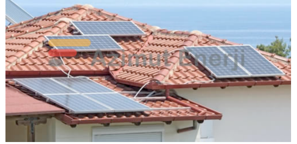
Solar Güneş Enerji Ev Sistemleri Kiremit Çatı Uygulaması.
