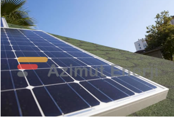
Solar Güneş Enerji Ev Sistemleri Shingle malzeme üzeri solar panel.
