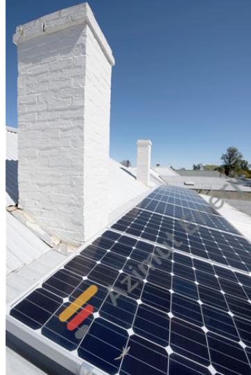
Özel çatı mimarisine uygun solar çatı uygulamaları Uygulaması.
